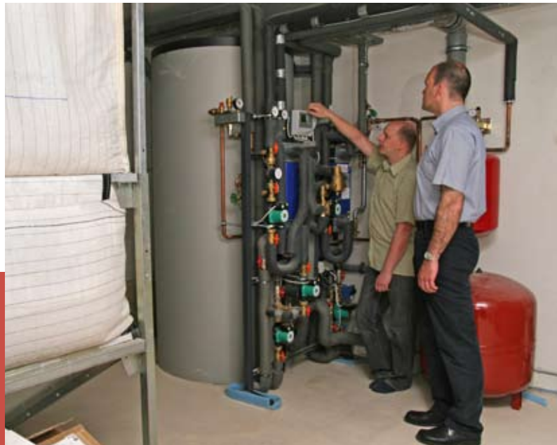
Tjark Paus (links) präsentiert stolz das Herzstück seiner technischen Anlagen (Pufferspeicher in Kombination mit der Solaranlage) und zeigt sich gegenüber Roland Stüber (Geschäftsführer von Stüber Haus, rechts) sehr zufrieden.
