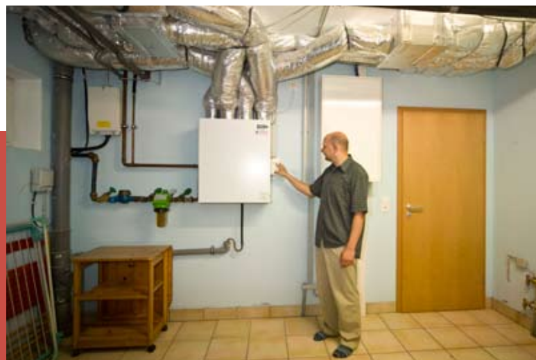
Schon ein relativ kleines Sack-Silo (links) reicht für die Lagerung der Pellets aus. Die Anlage zur kontrollierten Lüftung mit Wärmerückgewinnung (rechts) war für Energieoptimierer Paus Pflicht.
