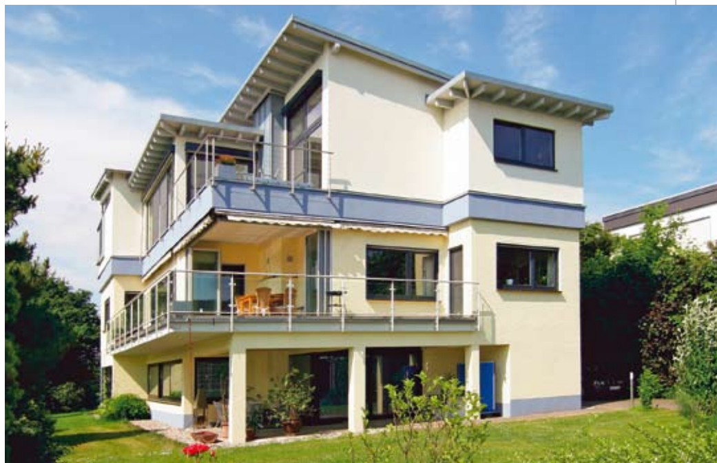
Das ursprünglich zweigeschossige Gebäude wurde mit Fertigteilen um ein Geschoss erweitert. Im Erdgeschoss liegen Eingang und Büroräume.
